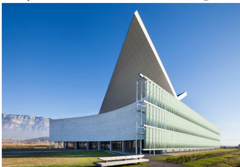
Fig. 1 : Face Nord du bâtiment de l'Institut National de l'Énergie Solaire. Le cadran solaire occupe tout le voile courbe en béton brut qui mesure 52 m de long sur 10 m de haut (photo Mathieu Ducros).
