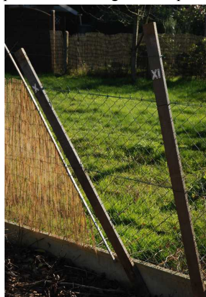
Palissade finale en remplissant les espaces et enlevant les planches
