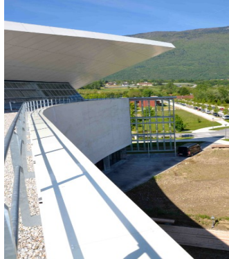
Fig. 3 : Vue de la partie Ouest du voile de béton. Au sol se dessinent les ombres du voile de béton et de l'écope qu'il surplombe. Au second plan, la Montagne du Chat.
