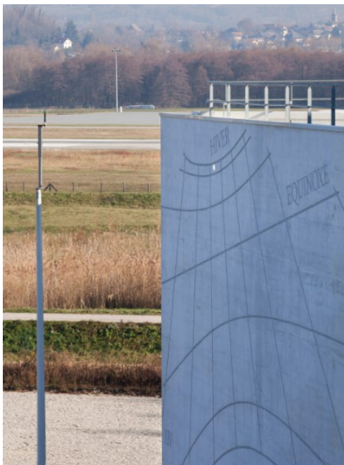
Fig. 22 : Sur cette photo du cadran du matin prise au mois de décembre, on voit la tache de lumière projetée par le miroir 1 situé en haut du mât (photo Mathieu Ducros). ▼
