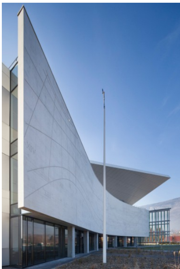
▲ Fig. 16 : Vu du sol, le miroir 2 est très discret. Il est fixé à la structure métallique latérale qui supporte des panneaux de verre qui tournent au cours de la journée pour équilibrer la température dans le bâtiment.
