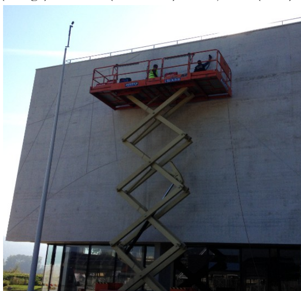
Fig. 18 : Une fois les lignes horaires et les courbes des dates implantées à l'aide d'un théodolite laser commence le difficile travail de gravure sur le béton, ici sur le cadran solaire du matin.
