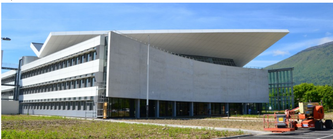
Fig. 6 : L'écope recouverte de capteurs solaires est située au-dessus du bâtiment. Elle est orientée vers le Sud. Par rapport au voile de béton qu'elle surplombe, elle crée un obstacle très contraignant qui nécessite d'installer deux miroirs pour capter le Soleil du matin au soir sans hiatus.
