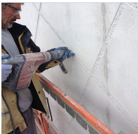
Fig. 19 : Détail de la gravure du béton à la défonceuse. C'est un travail minutieux et particulièrement difficile qui s'est étalé sur plusieurs semaines en raison de la longueur de l'ensemble des lignes horaires et des courbes.
