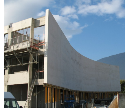
Fig. 4 : Détail du voile de béton. Après avoir été coulé en une seule fois, le voile est maintenant sec mais encore soutenu par des étais. Le haut du voile est à 12,66 m du sol.
